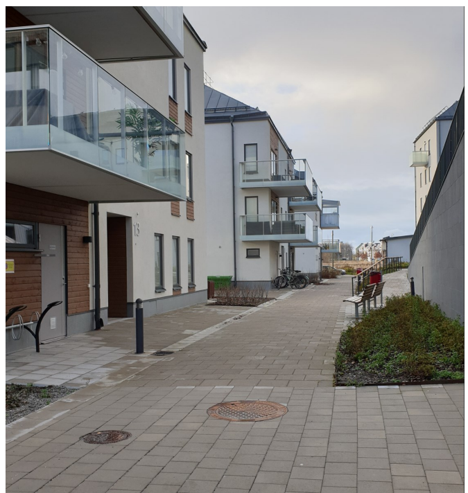
Gårdsstråk inom kv. Startbanan, sett från öst till väst mot fastigheten Startbanan 5.
