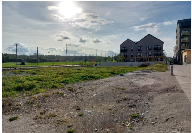
Fastigheten sedd från nordöstra hörnet.
